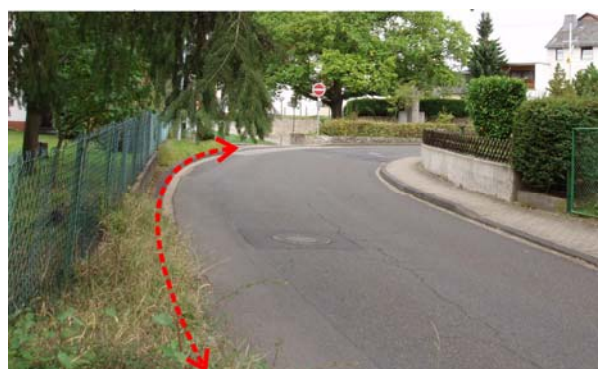
Fehlender Gehweg (links)
