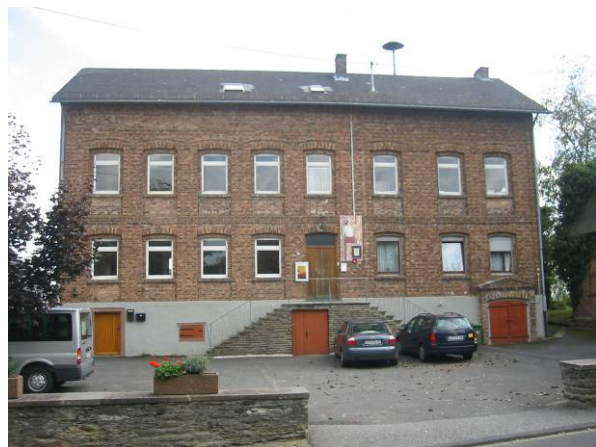
Abb.: derzeitiges Aussehen der Alten Schule
